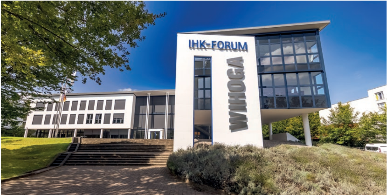
Das neue IHK-Forum nach dem Umbau der ehemaligen Hotel- und Gastronomie-Fachschule WIHOGA.
