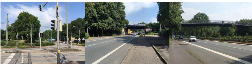
Abbildung 8-13: Hindernisse auf dem Nordstadtweg (Beispiele)
