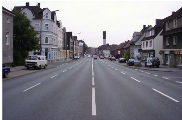
Abbildung 19: Rückbau der Provinzialstraße, Situation vorher (oberes Bild) und nachher (unteres Bild) 66
