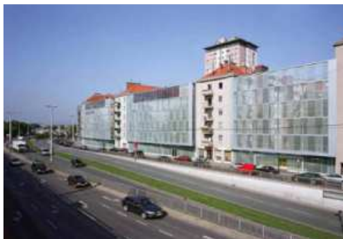
Abbildung 22: Beispiele für aktiven Lärmschutz durch Baulückenschließung (oben) 83 und begrünte Lärmschutzwände zur Grundstückseinfassung (unten)
